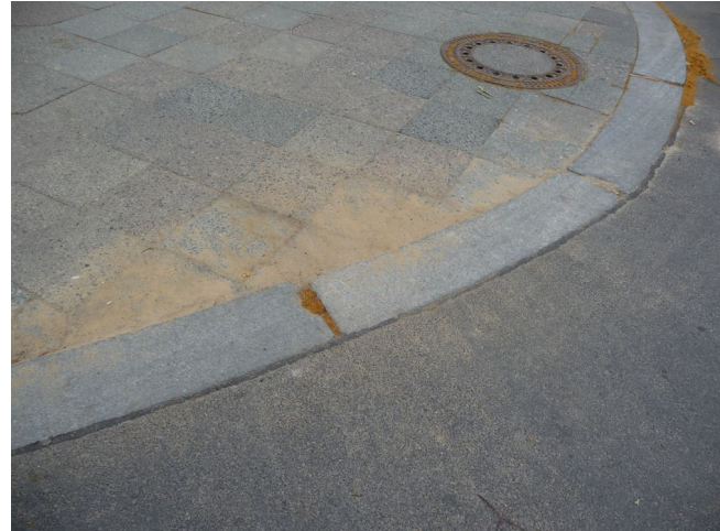
Bild 2: Hedwigstraße in Berlin-Friedenau: Nach Straßenreparatur wurde eine echte Nullabsenkung erreicht. Der den Bordstein begleitende dunkle Streifen ist nicht etwa der Schatten der 3-cm-Kante, sondern ein Bitumenausguss der vollständig waagerechten Fuge. Die nach AV Geh- und Radwege vorgeschriebenen Aufmerksamkeitsfelder auf der Gehwegseite der Bordsteine wurden nicht verlegt.
