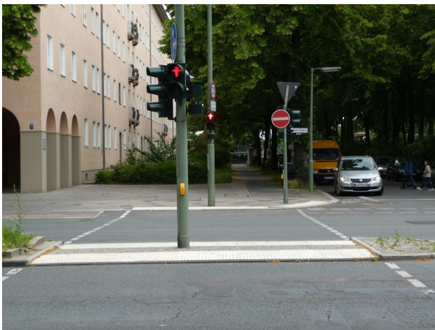
Bild 3: Vorbildlich ausgestattete Kreuzung in Berlin-Steglitz, Grazer Damm / Ecke Grazer Platz. Vollständig ausgestattete Blindenampeln nach DIN 32981 mit Umgebungslärm-abhängig geregelter Lautstärke sowohl des Orientierungssignals = Auffindesignal und des Freigabe-Signals Zeit-parallel zum Fußgänger-Grün. Siehe T-113 auf Seite www.i5b.de .
